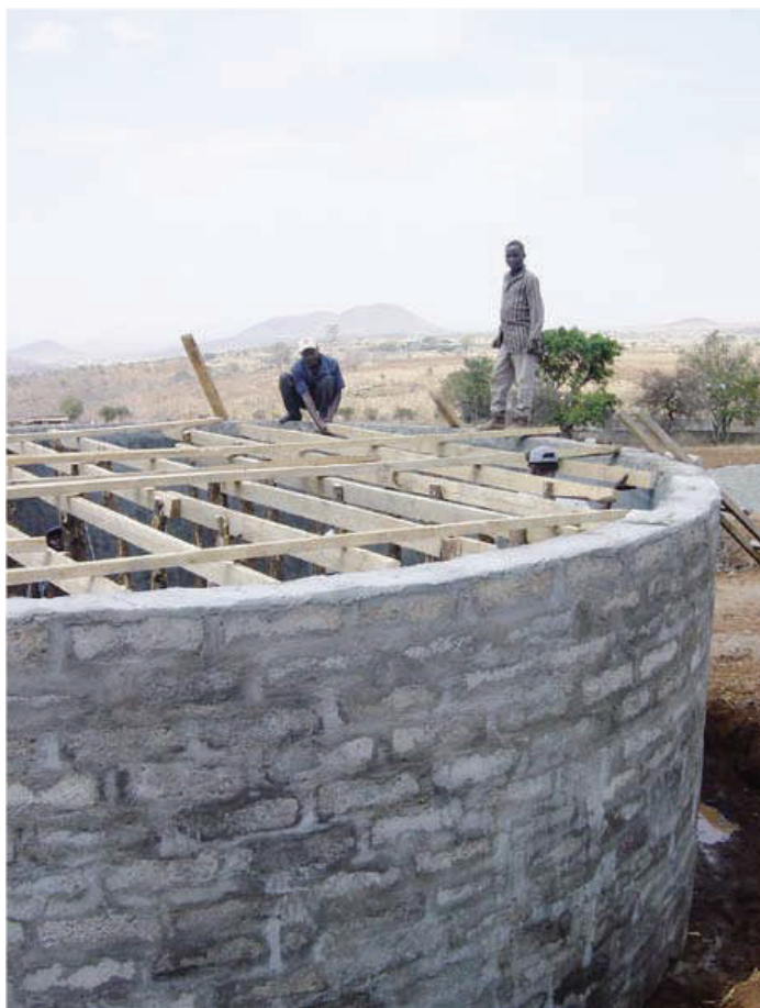
تصویر (۳) ساخت مخزن ذخیره با بلوک‌های بتنی، تانزانیا
