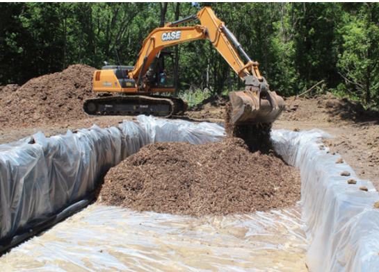
شکل ۴ - تصویری از حفر تراشه بیوراکتور تراشه چوب
